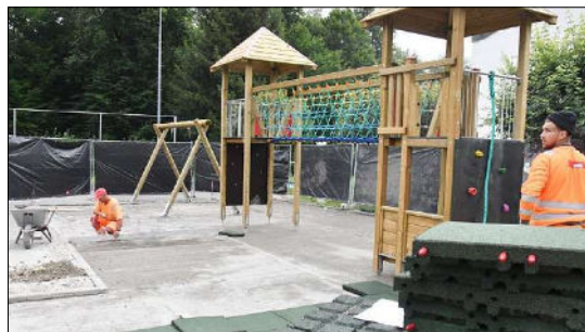
Die letzten Bodenplatten werden gelegt, damit Klettergerüste und Schaukeln rechtzeitig für die Sommerferien spielbereit sind. Foto: hhs
